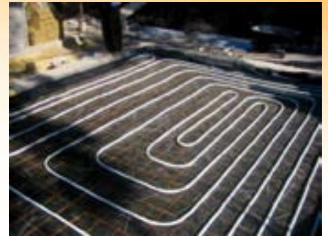
Mise en place de l'échangeur de chaleur.
